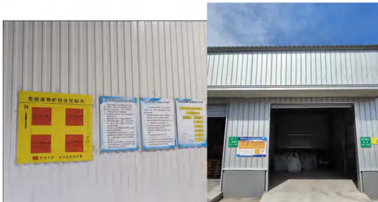
图4-3 项目危废暂存间
